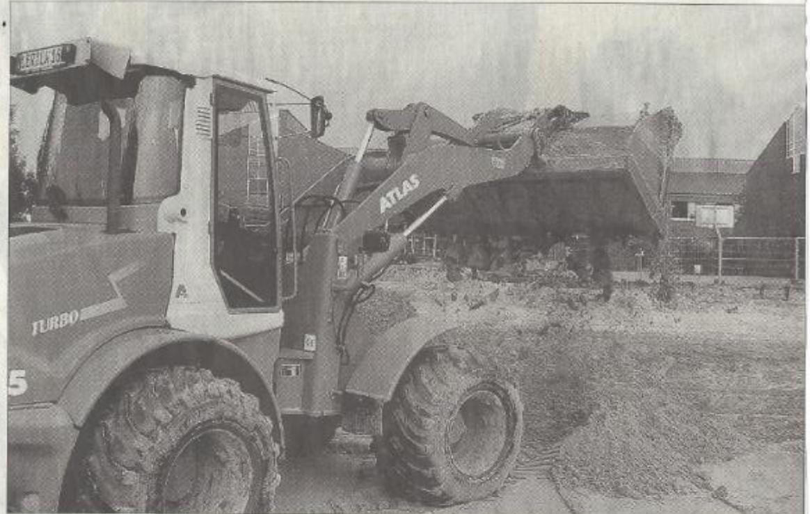
Mit einem Radlader wird der Füllsand verteilt. Zuvor war der nichttragfähige Moorboden ausgekoffert worden.
