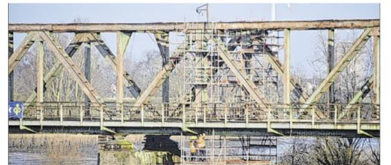
Mit Hilfe des Kranes soll der Überbau Nummer 4 von der Brücke gehoben werden. Aktuell laufen die vorbereitenden Arbeiten.
