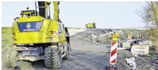
Am Deichfuß sind Spundwände in den Boden gerammt worden. Aktuell wird in Hilkenborg in der Nähe der Friesenbrücke eine Zuwegung über den Deich gebaut.
