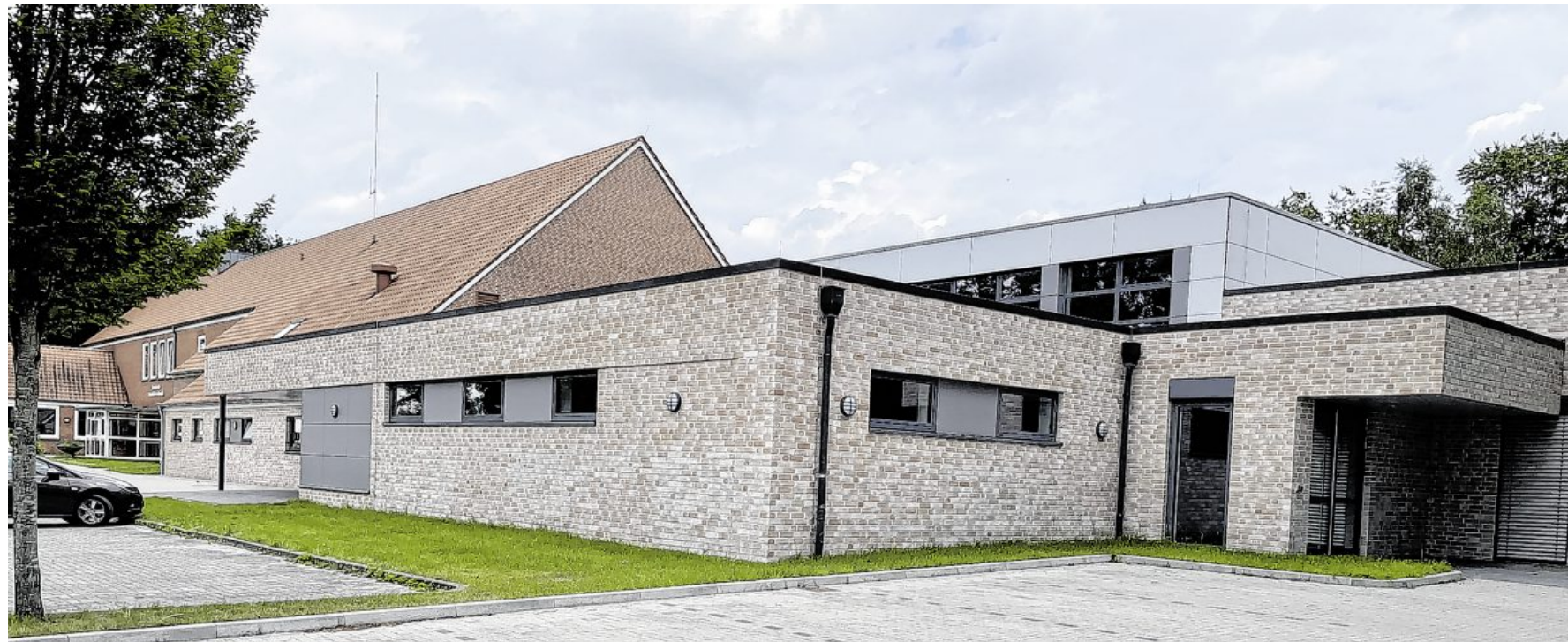
In dem neuen Anbau an dem Gebäude der Grundschule Steenfelde und der Turnhalle wird das Orff-Studio untergebracht. Der Komplex ist fertiggestellt worden, wegen der Corona-Pandemie fand eine offizielle Eröffnung noch nicht statt.
